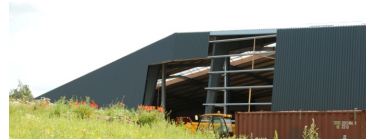
Bygningen er beklædt med tyndpladeprofiler i stål, monteret på åse og profileret i tyndpladestål. Et skelet med en "tynd hud" som klimaskærm
