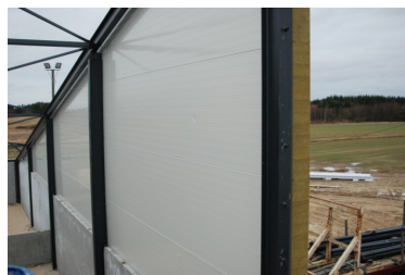
Et isoleret sandwich-element i den øverste del af svinestaldsbyggeriets gavle
